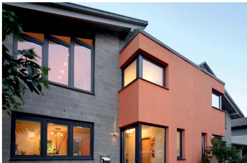
Mit Farben Akzente an Fassade und Fenster setzen
